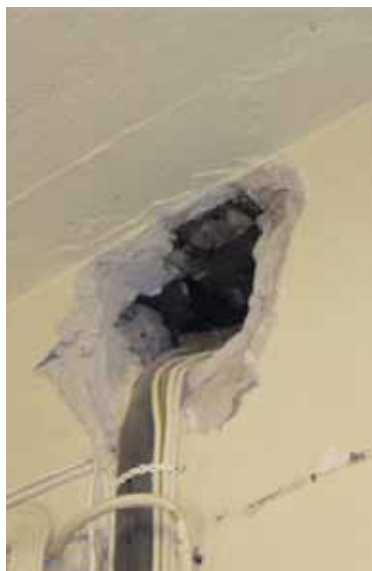
BYGG F OGG: Eksempel på ventilasjon.
