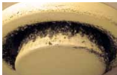
HYGIENISK? Skitten luftsventil på sengeposten, med sårbare pasienter i nærheten.
