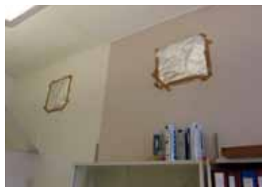
BYGG F OGG: Innluft som må tettes på grunn av trekk.
