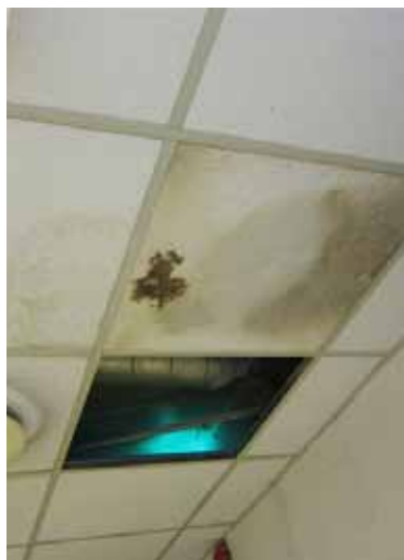
SKJOLDETE: Gammel fuktskade.
