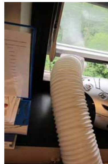
BYGG A OGB: Fjerning av overskuddsvarme fra kjølevifte.
