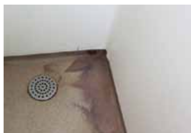
BYGG A OGB: Muggsopp i dusjer.
