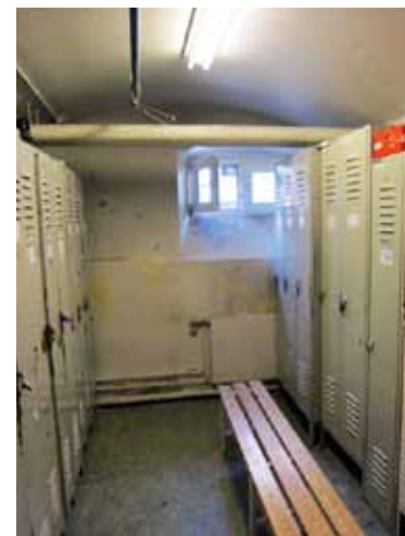
GARDEROBE, KJELLER: Skapene rustet og malingen på veggene flusser av.
