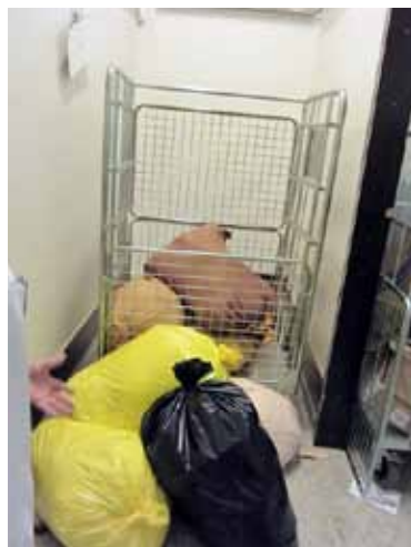
SNUBLEVEI: Rømningsveien er blokkert på ulovlig vis.
