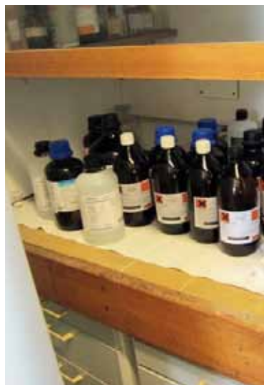
BYGG F OGG: Lagring av kjemikalier. Avtrekkskap (gammelt og ikke i bruk). Dårlig avtrekk. Tilkoblet??
