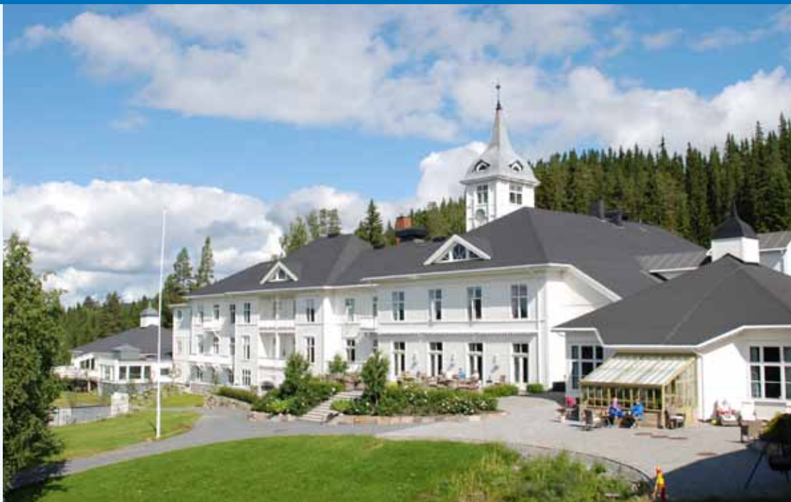
FLOTT BYGNING: Hovedhuset til Montebello senteret er en herskabelig trebygning fra 1898 som ble restaurert til dagens bruk i 2009. Senteret har 44 moderne pasientrom. Foto: Montebello senteret.
